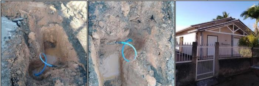
Figura 9 – Conserto de Ramal Rua Nossa Senhora Aparecida
