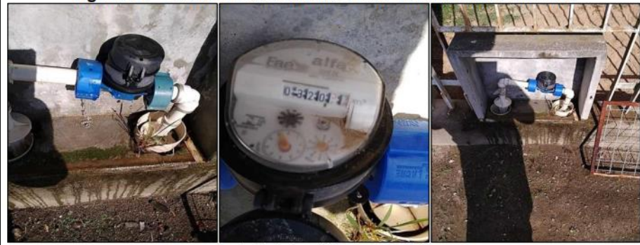
Figura 16 – Conserto de Cavalete Rua Vândio Mário da Silva
