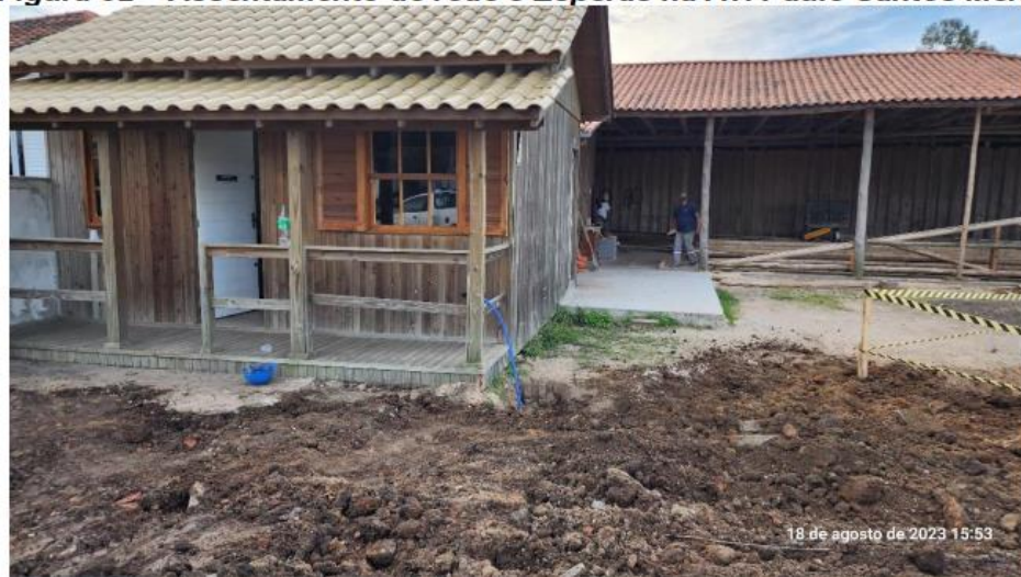
Figura 32 – Assentamento de rede e Esperas na Av. Paulo Santos Melo
