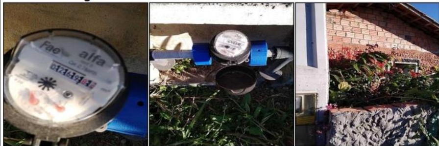
Figura 2 – Vistoria de Hidrômetro Rua Castro Alves
