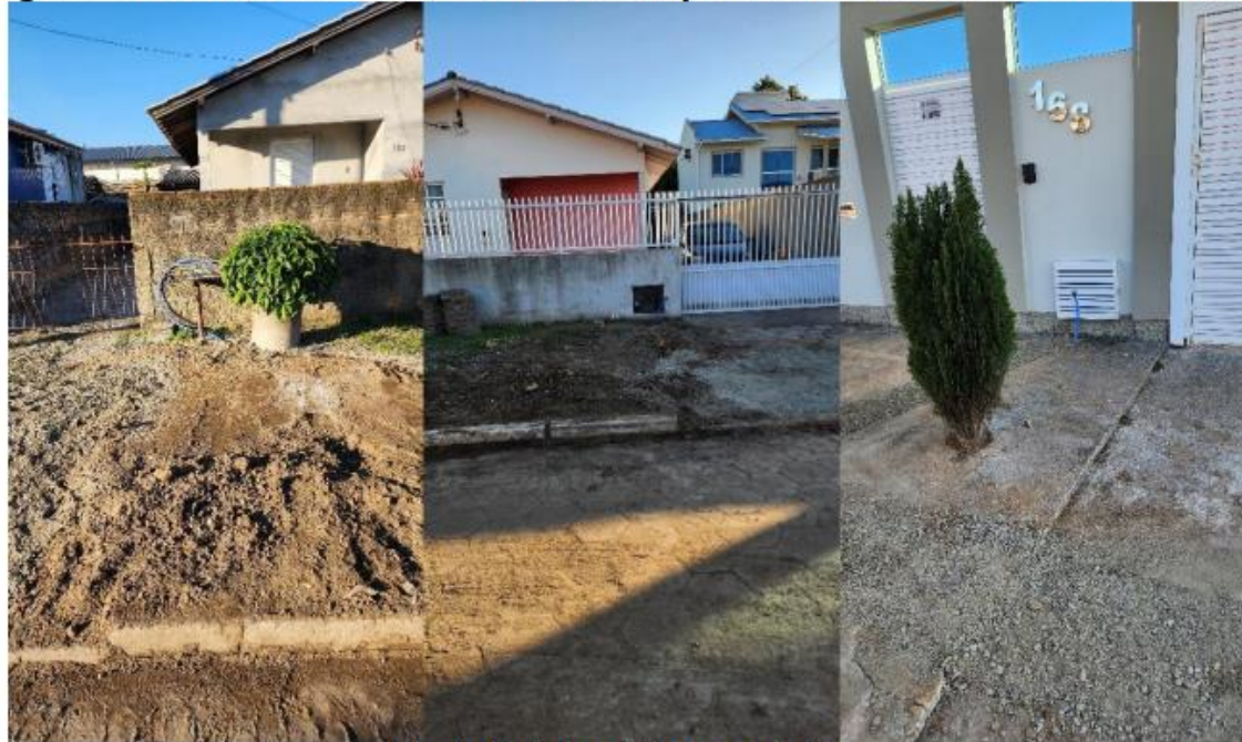
Figura 30 – Assentamento de rede e Esperas na Rua Doraci Rosa Osório
