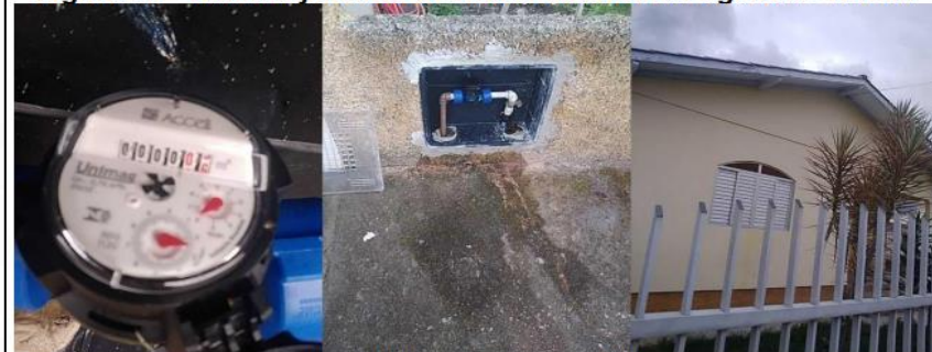
Figura 23 – Remanejamento de Hidrômetro: Rua Fagundes Varela
