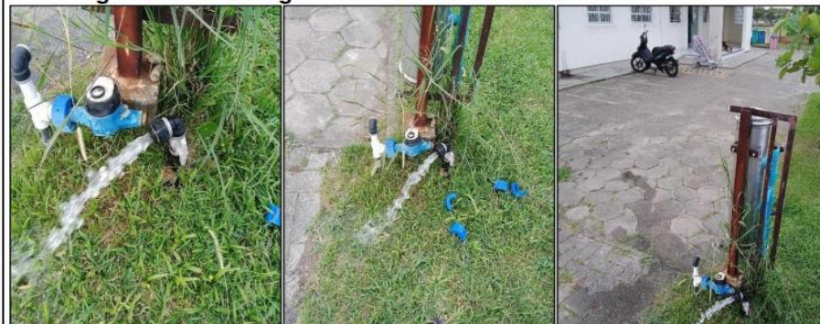
Figura 19 – Descarga de Cavalete Rua Manoel Zeferino da Silva
