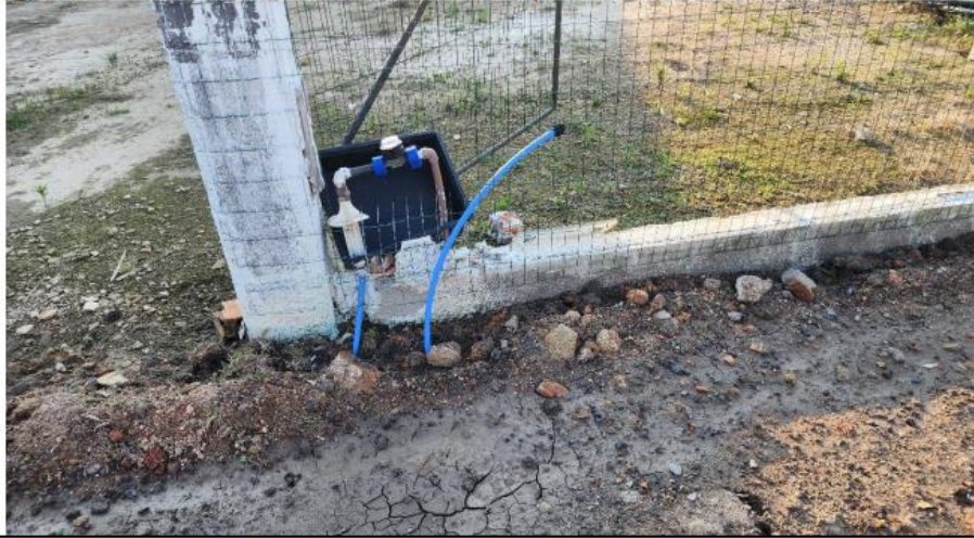
Figura 33 – Assentamento de rede e Esperas na Rua Doraci Rosa Osório
