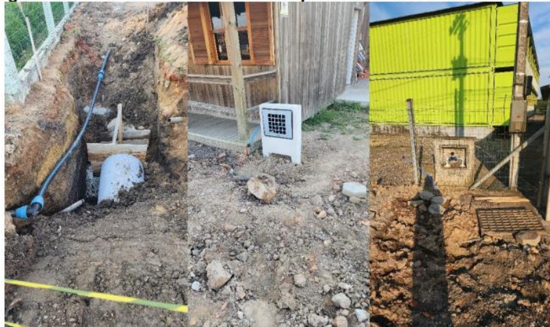
Figura 34 – Assentamento de rede e Esperas na Rua Doraci Rosa Osório
