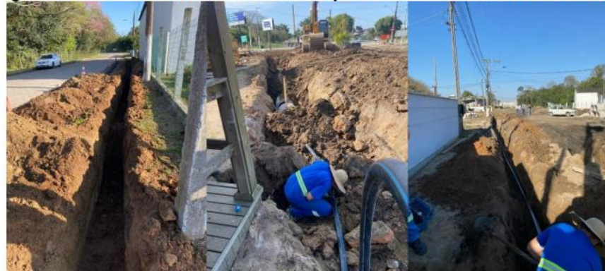
Figura 35 – Assentamento de rede e Esperas na Rua Doraci Rosa Osório
