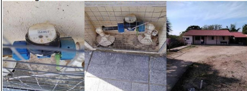
Figura 22 – Vistoria de Hidrômetro: Rua Rafael Luciano
