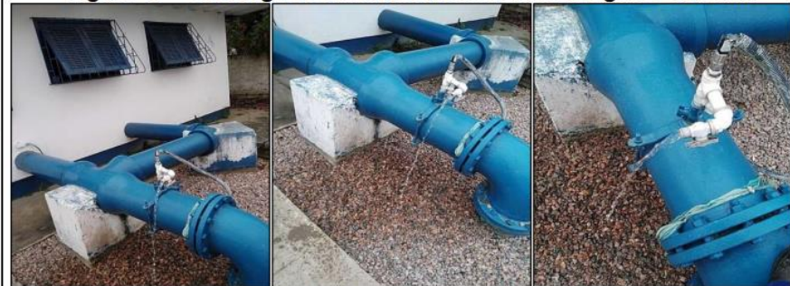
Figura 15 – Descarga de cavalete Avenida Nilton Augusto Sachetti
