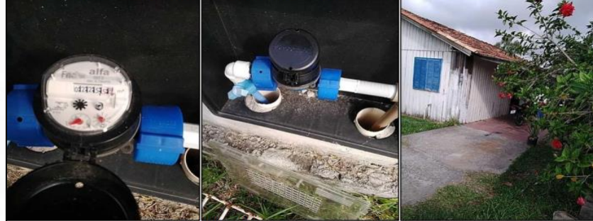
Figura 20 – Vistoria de Hidrômetro Rua Danil Thomaz de Oliveira
