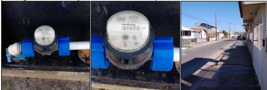
Figura 5 – Remanejamento de Hidrômetro para Padrão Rua João Goulart
