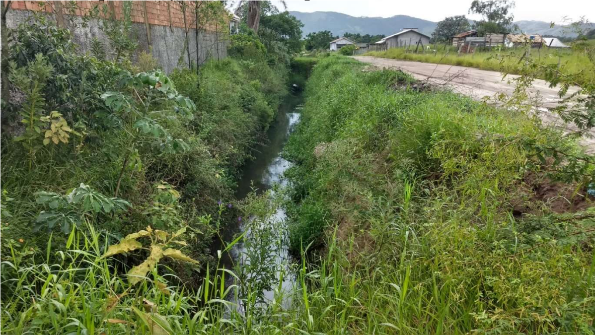
Figura 82: Aspecto da Macrodrenagem urbana – Vala Três de Maio.
