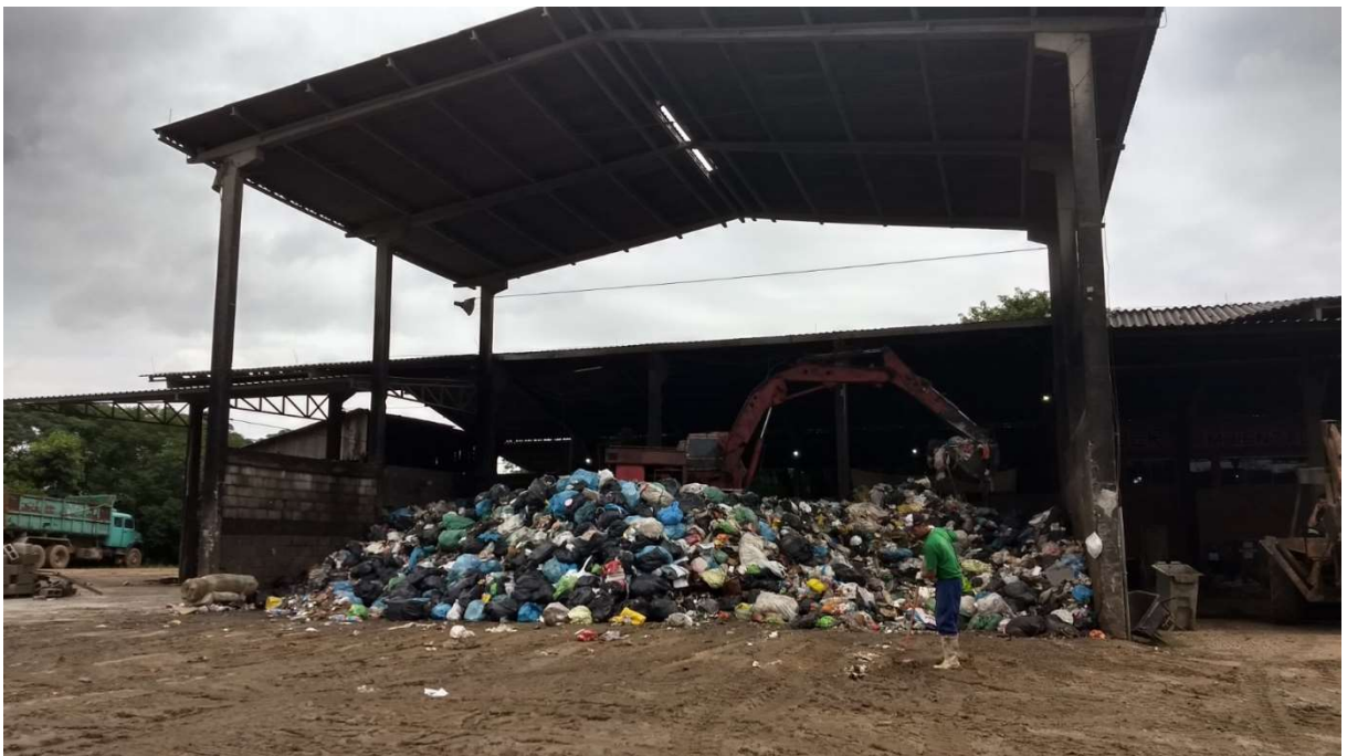
Figura 48: Local de Descarregamento dos Resíduos pelos caminhões coletores.
