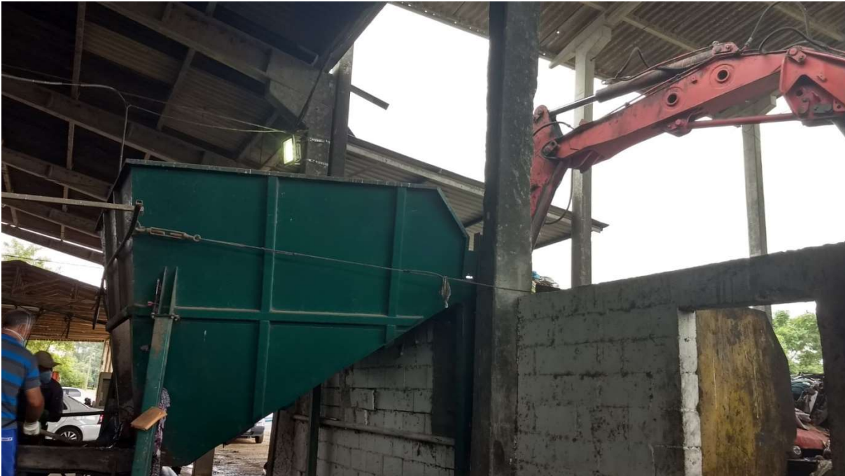
Figura 49: Entrada dos resíduos à esteira de triagem com auxílio da retroescavadeira.
