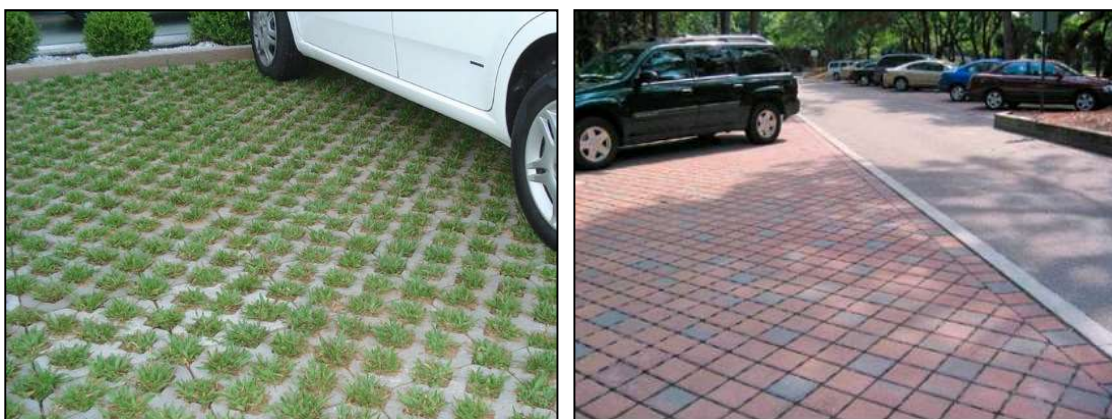
Figura 105: Exemplos de Pavimentos Permeáveis.
