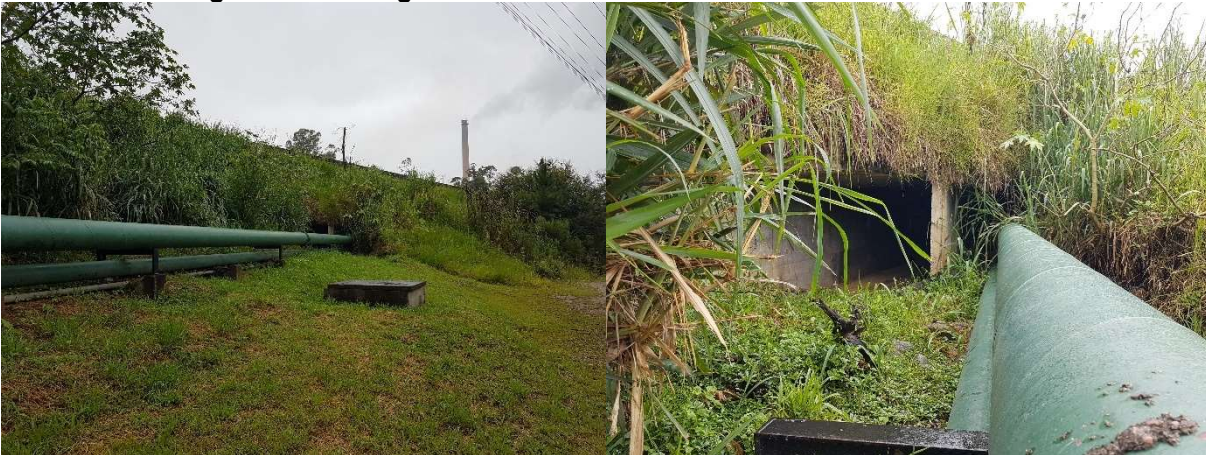
Figura 90: Passagem Sob a BR 101 da Atual da Adutora da ENGIE.
