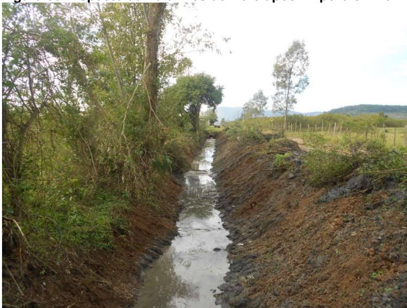
Figura 83: Aspecto da Vala Três de Maio após limpeza em 2012.
