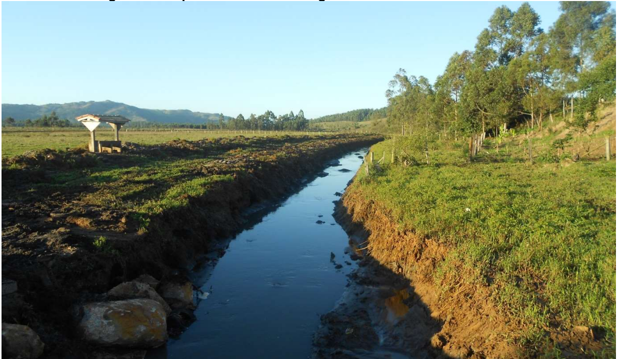
Figura 84: Aspecto da Macrodrenagem urbana – Vala Santa Lucia.
