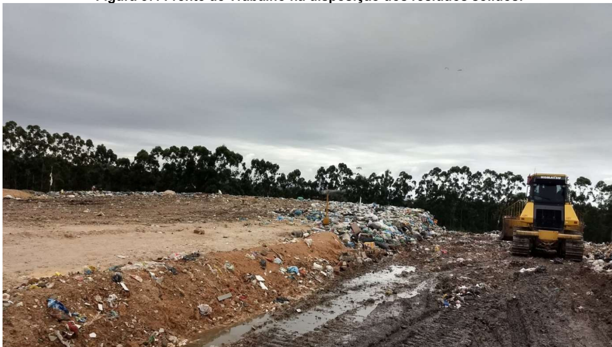
Figura 57: Frente de Trabalho na disposição dos resíduos sólidos.
