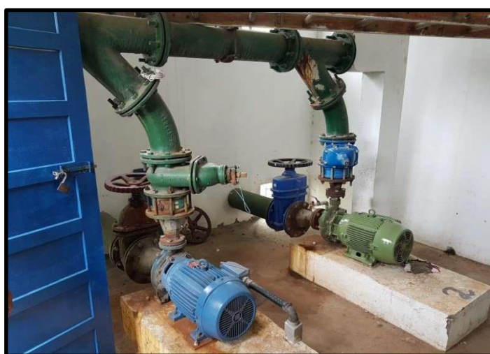
Figura 6: Conjuntos moto bombas da ERAT 1.
