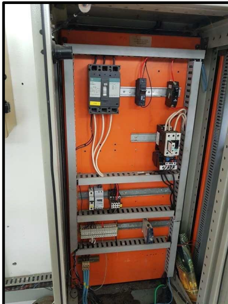
Figura 7: Acionamento dos Conjuntos motobombas
