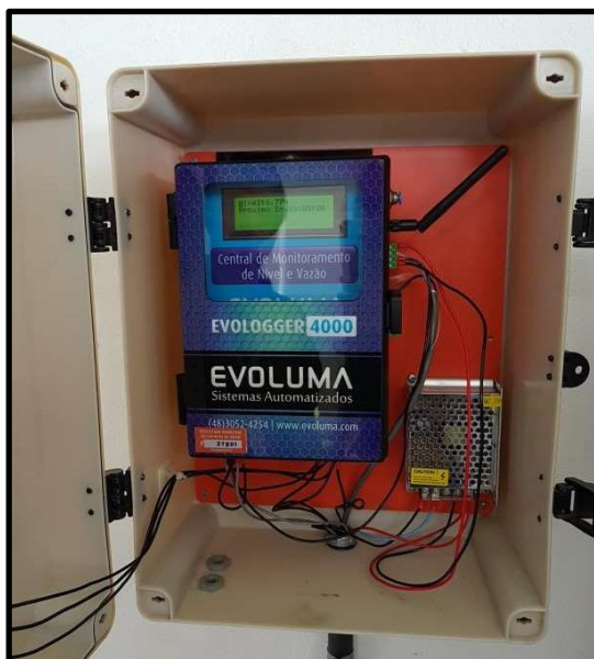
Figura 8: Sistema de Telemetria.
