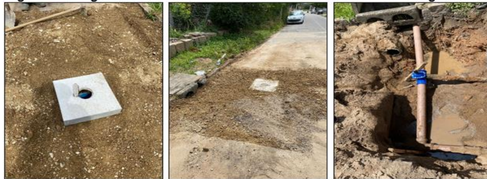
Figura 13 – Registro DN100 instalado na Rua da Liberdade como descarga de rede.
