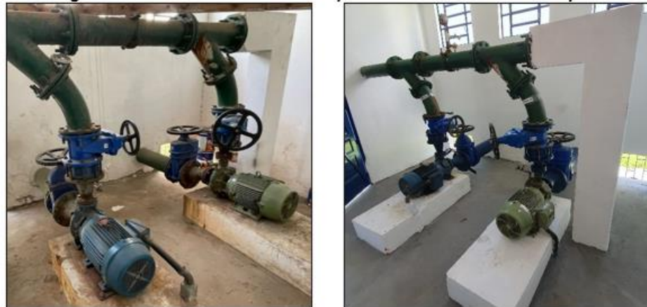
Figura 17 – Pintura interna Recalque 02 Paraiso – Antes e Depois
