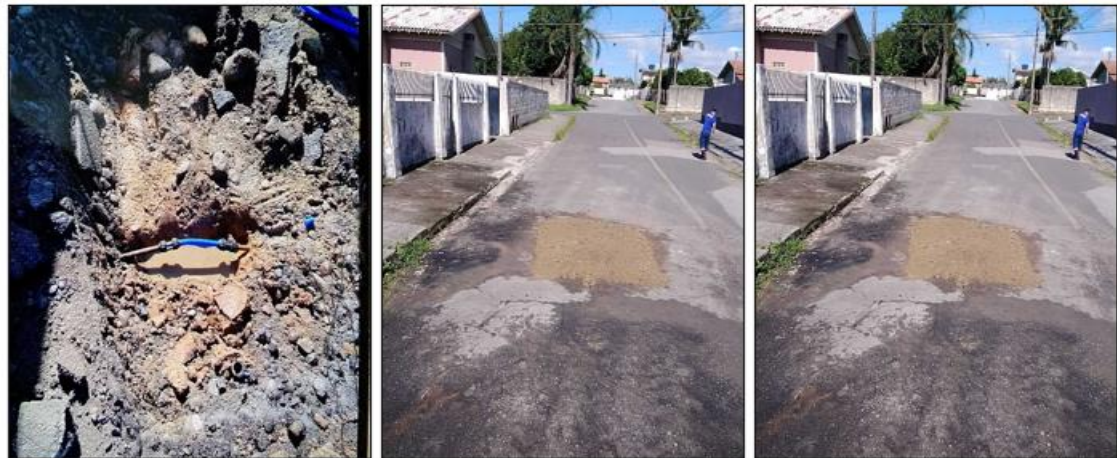
Figura 9 – Conserto de Ramal Rua Manoel João Rodrigues
