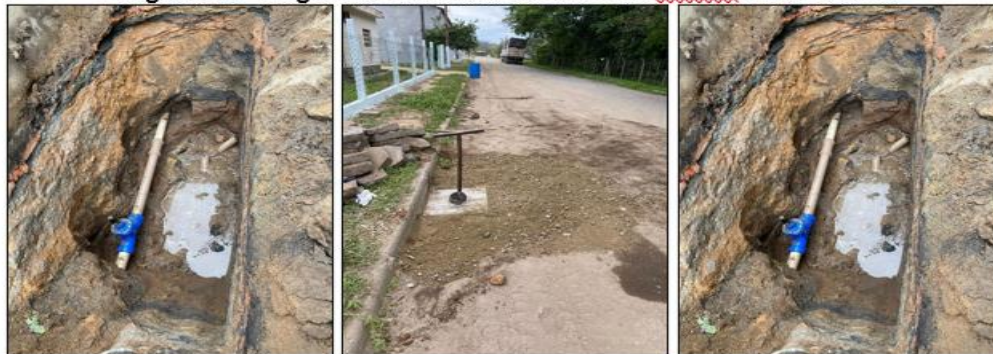
Figura 12 – Registro DN50 instalado na Rua Doraci Rosa Osorio
