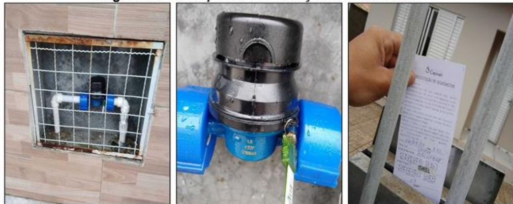
Figura 15 – Exemplo de Substituição de Hidrômetro
