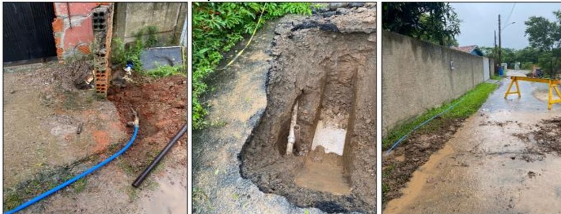
Figura 2 – Capeamento de Rede Rua Vândio Mário da Silva – Devido Problemas no Bairro Santo André após Chuvas + Ramal Provisório
