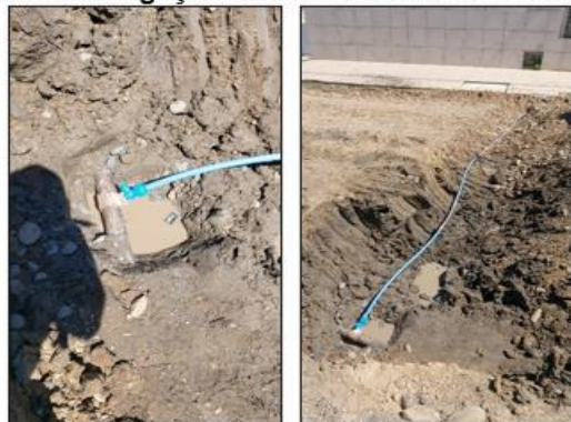
Figura 16 – Remanejamento de Ligação na Rua Maria da Silva Alves devido pavimentação
