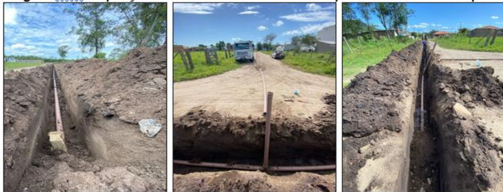
Figura 14 – Ampliação de rede Rua Manoel Vieira Esquina com Manoel Joaquim
