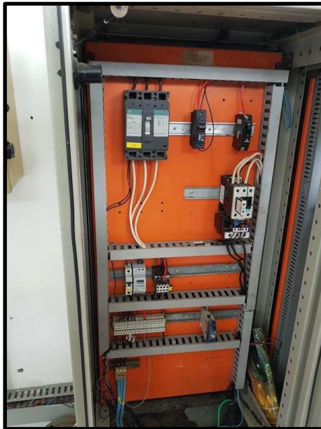
Figura 7: Acionamento dos Conjuntos motobombas
