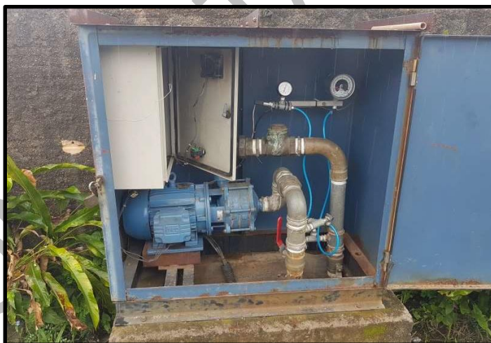
Figura 10: Booster Santa Lúcia e Caixa de Abrigo do Painel e Conjunto motobomba.
