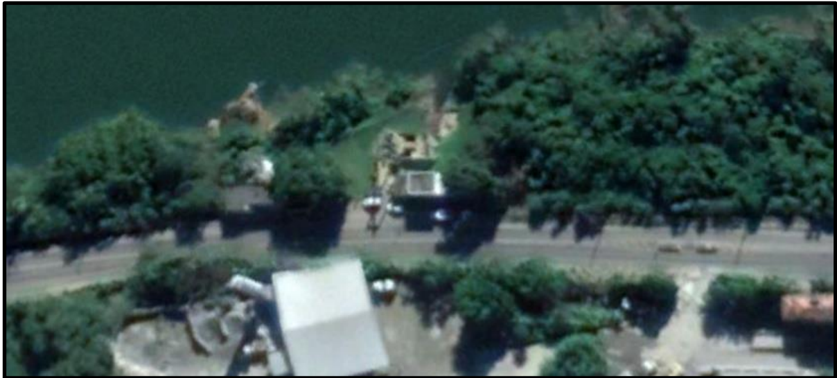
Figura 3: Vista Superior da Captação no Rio Tubarão, no município de Tubarão
