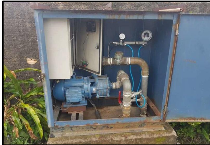
Figura 17: Booster Santa Lúcia e Caixa de Abrigo do Pannel e Conjunto motobomba.
