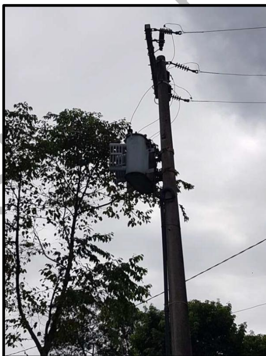
Figura 11: Transformador Instalado no Booster de Entrada.
