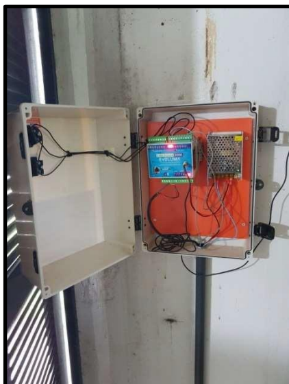
Figura 10: Sistema de Telemetria
