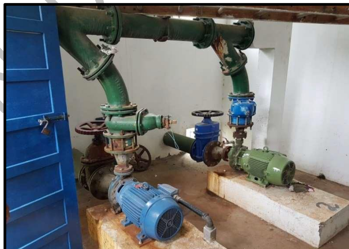
Figura 13: Conjuntos moto bombas da ERAT 1.
