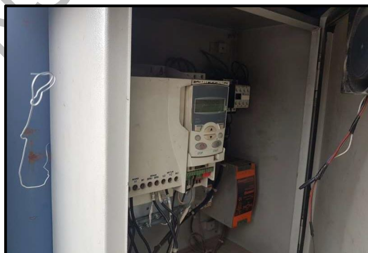
Figura 18: Acionamento do Booster Santa Lúcia.
