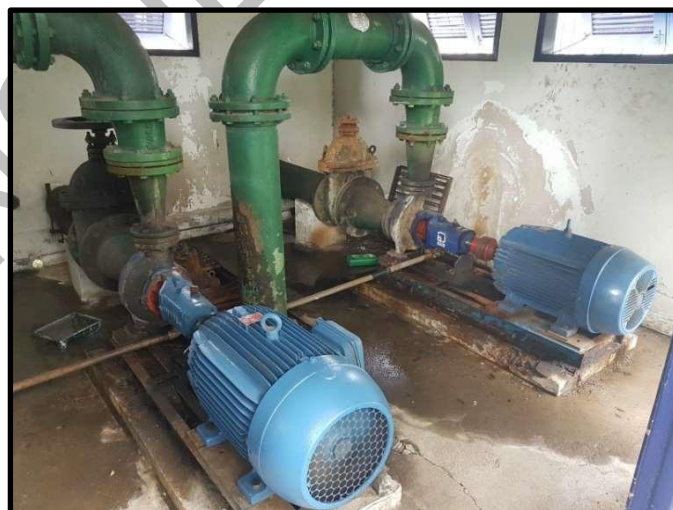
Figura 8: Conjuntos Motobombas.
