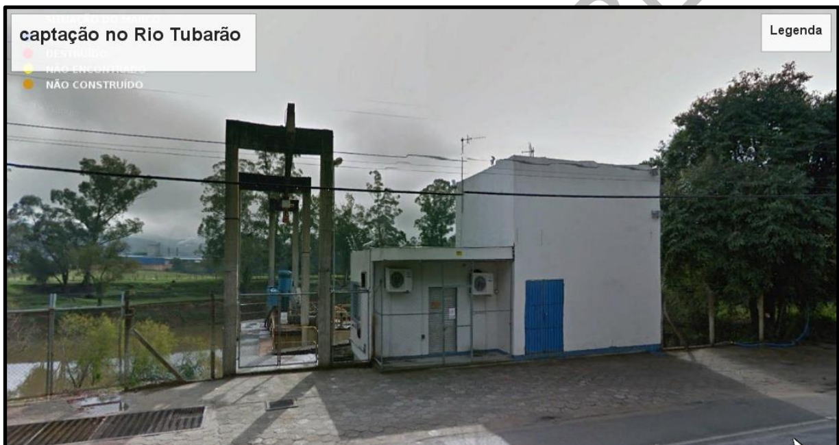
Figura 4: Captação no Rio Tubarão – Vista Frontal
