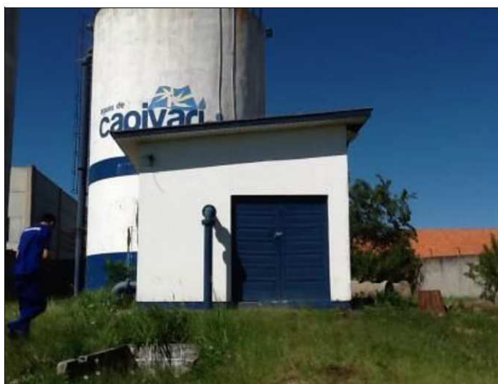
Foto – Reservatórios R-1
