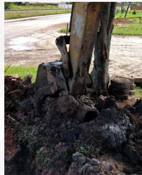
Rua Manoel Pedro Flor – em frente a Igreja troca de 12 tubos
