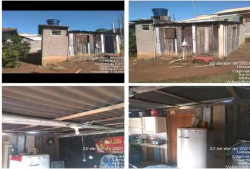
Legenda: Relatório fotográfico Feito “in loco”. Local: Bairro Ilhotinha.
