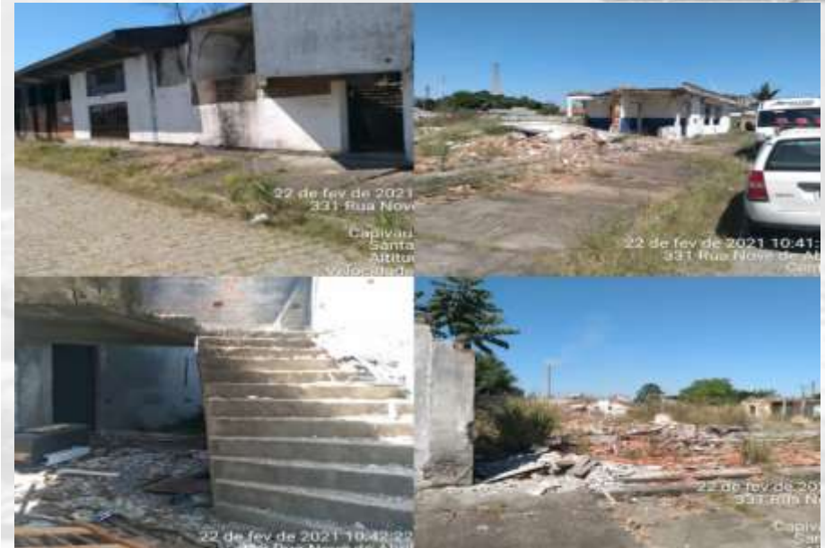
Legenda: Relatório fotográfico Feito “in loco”. Local: Bairro Centro, antigo clube siderurgia.
