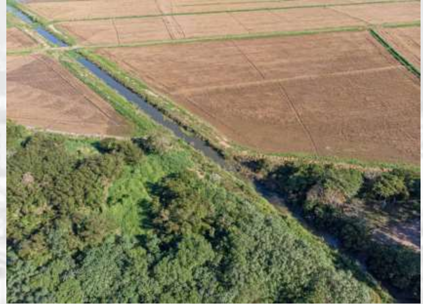
Legenda: Vista superior feita com Drone. Local: Canal da santa lúcia Fazenda agro avião.
