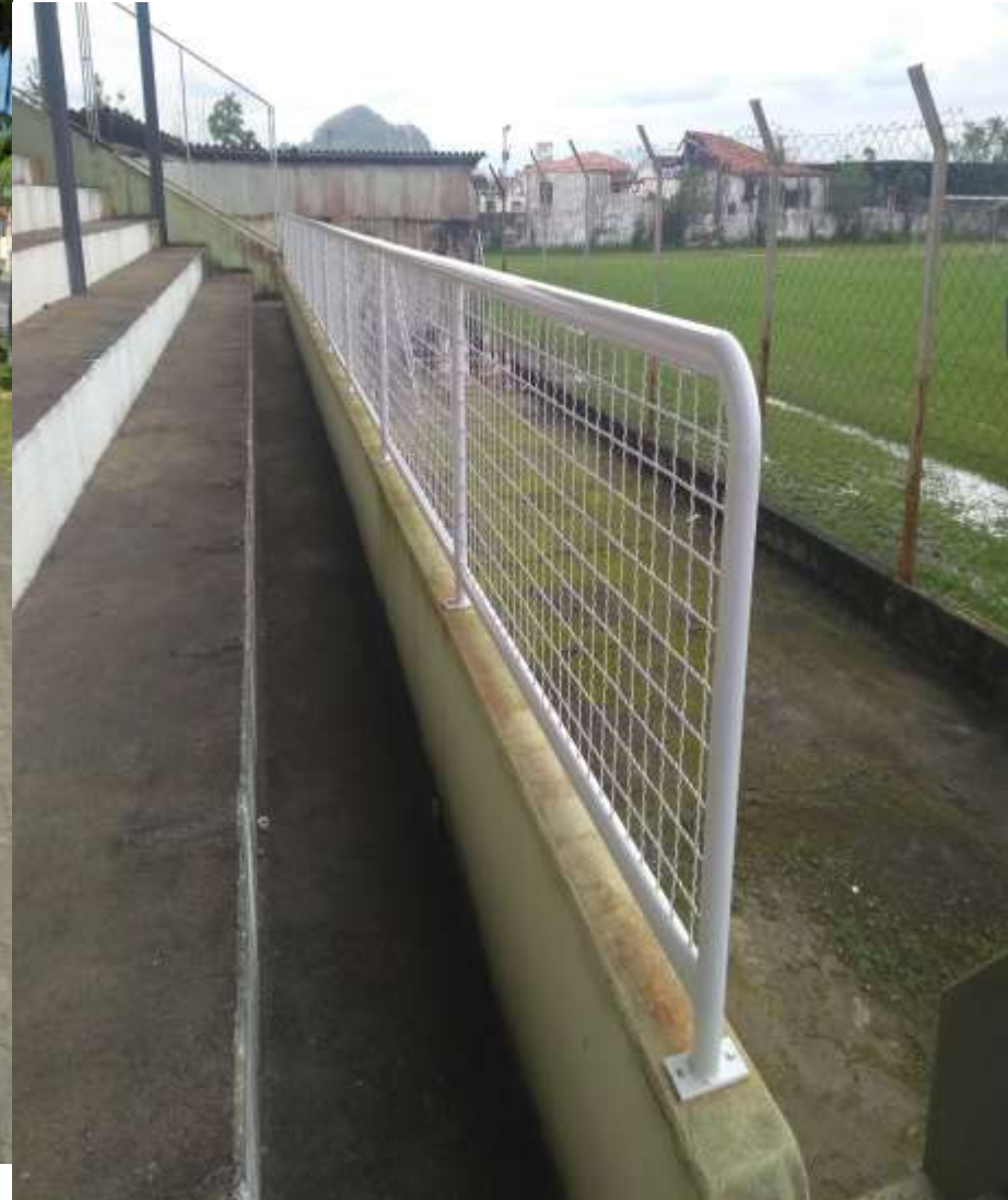
Reforma Campo de Futebol Adequação normas do corpo de Bombeiro (Corrimão)
