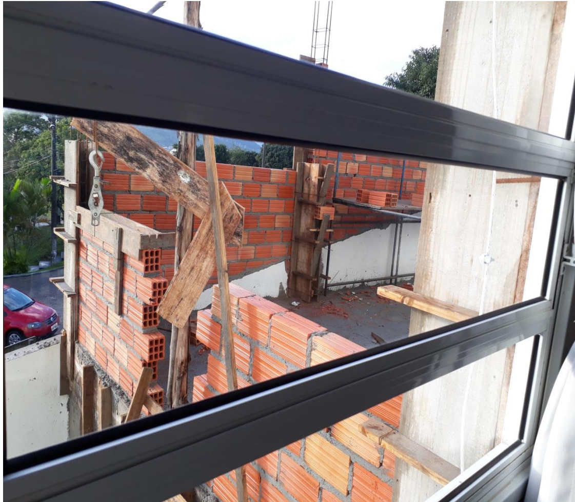
Obra em andamento
